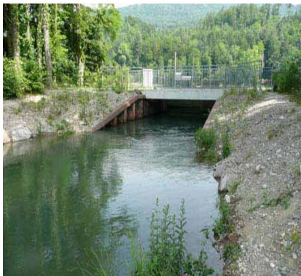
Abbildung 2: Einlaufbauwerk des Umgehungsgewässers
