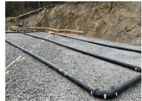
F.3 Drenaggio radon in PE
