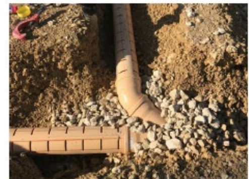
F.4 Drenaggio radon/acqua in PP
